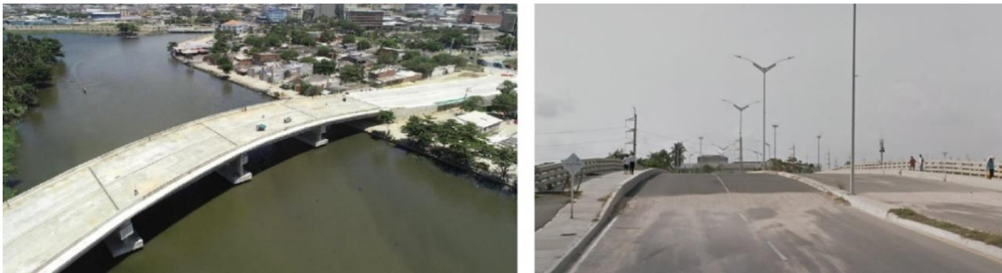
Figura 14. Izquierda, Puente Barlovento; Derecha, Puente sobre el Caño de los Tramposos. Fuentes: Izquierda, Portal web zonacero.com. Derecha, Google Street View.
