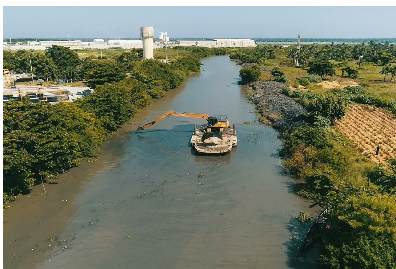
Ilustración 4. Trabajos de recuperación en los caños orientales (febrero 2022)
