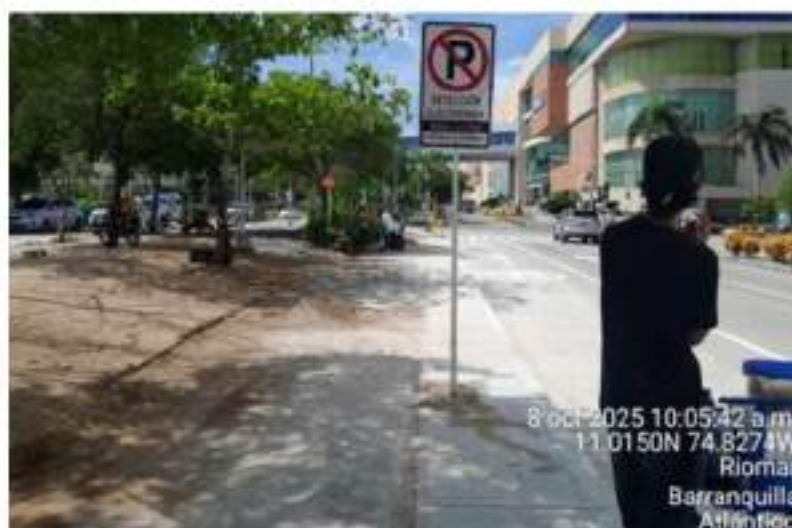
Figura 6 Tercer carril en Calle 99 entre Carreras 55 y 53
