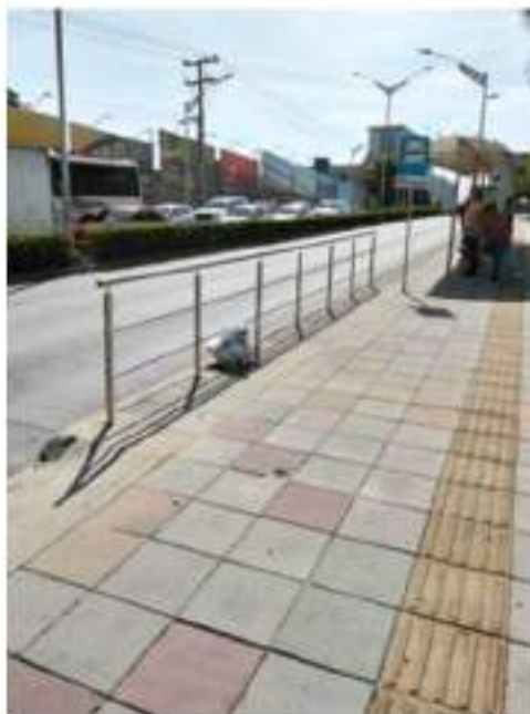
Figura 13 Instalación de barandas para lograr detención de buses en lugares destinados en Carrera 51B con Calle 98
