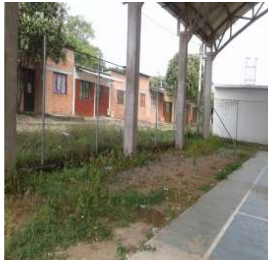
Fotografía N° 519. Cerramiento con maleza
