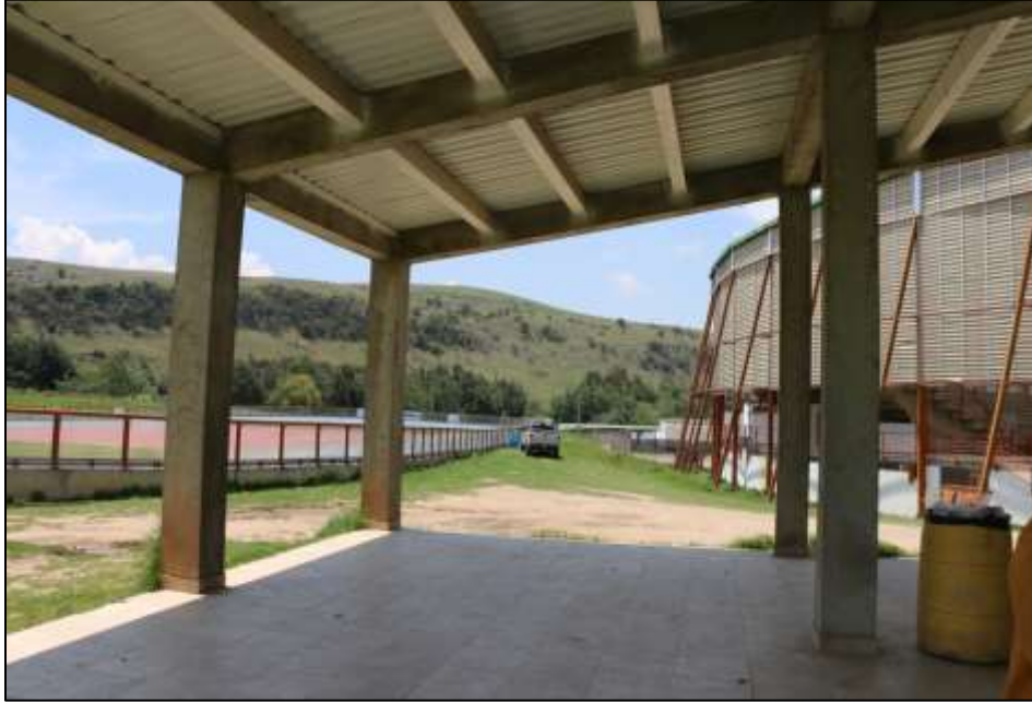
Fotografía 192. Vista general del espacio de circulación a un costado de las baterías sanitarias adecuadas. Se evidencia el tipo de estructura metálica de la cubierta, la cual corresponde únicamente a correas en perfiles tubulares rectangulares.
