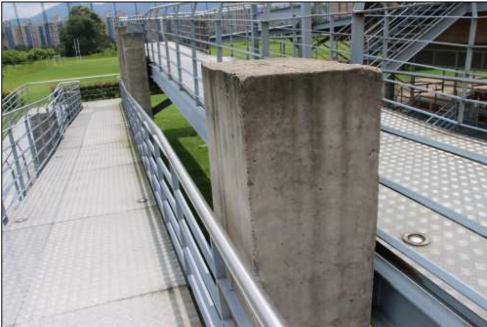
Fotografía 157. Detalle de una de las columnas de apoyo de la rampa de emergencia (vista, desde un tramo intermedio).
