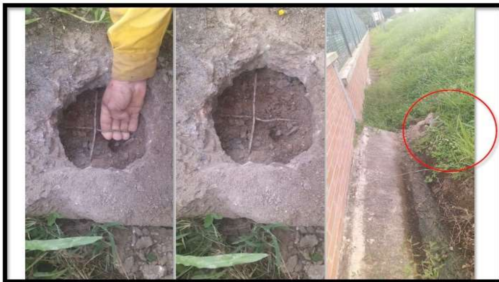
Fotografía 124. Verificación de refuerzo en cunetas
