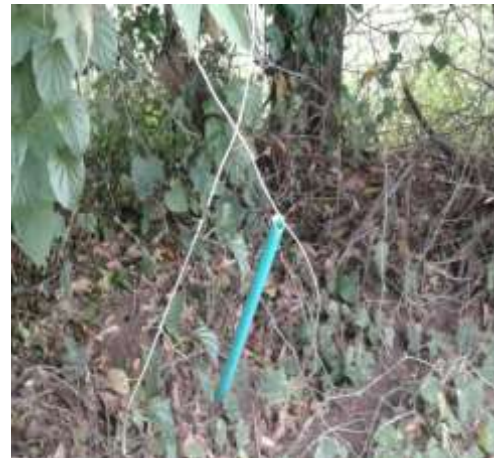
Fotografía N° 507. Redes eléctricas saqueadas
