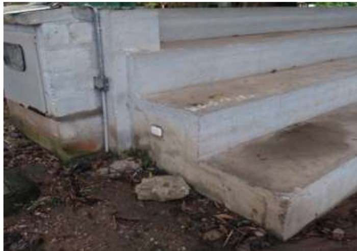
Fotografía N° 512. Detalle de los acabados eléctricos y de las graderías
