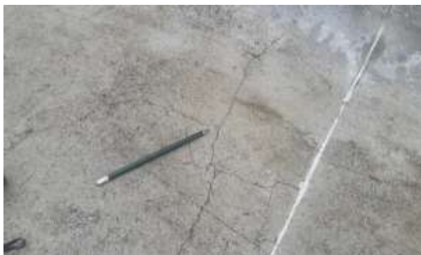
Fotografía N° 568. Fisuras presentadas
