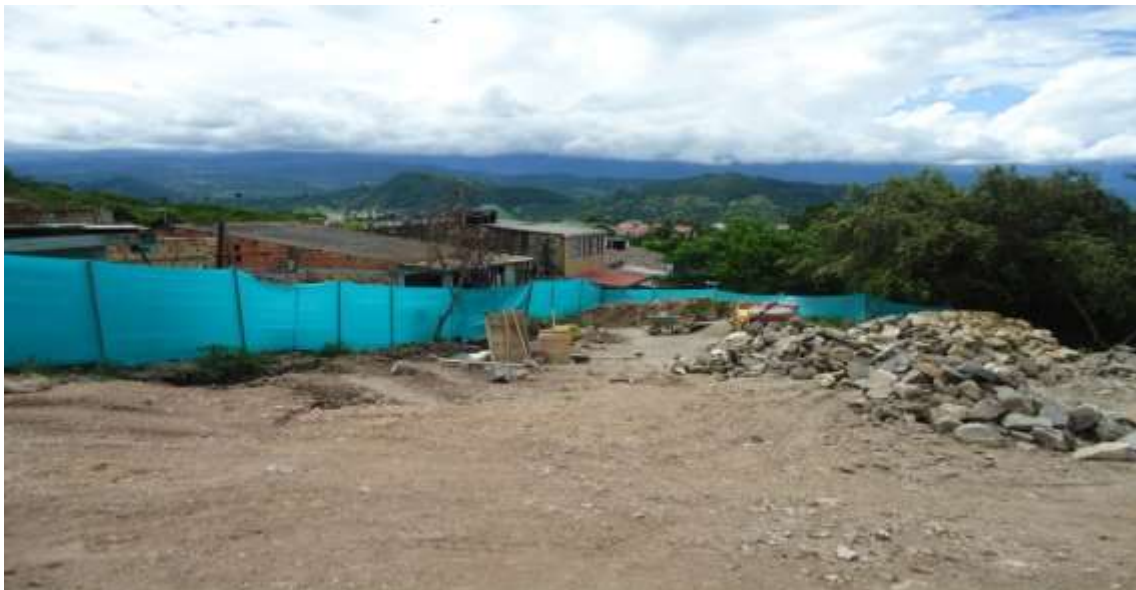
Fotografía 149. Vista general del terreno a construir. 26/04/2019
