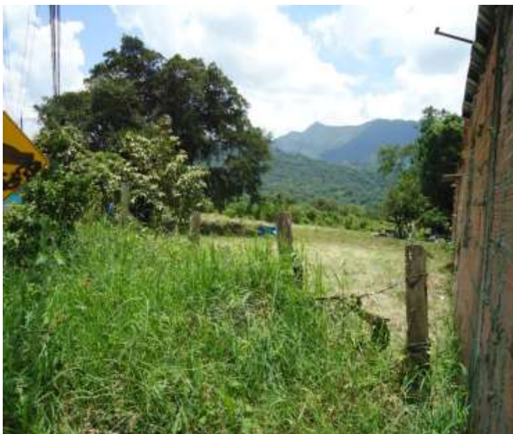
Fotografía 295. Vista lateral del terreno a construir. 04/04/2019
