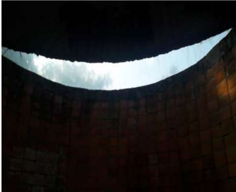
Fotografía N° 562. Apertura en donde no se instaló el Domo. Foto tomada por el Auditor el 04 de abril de 2019
