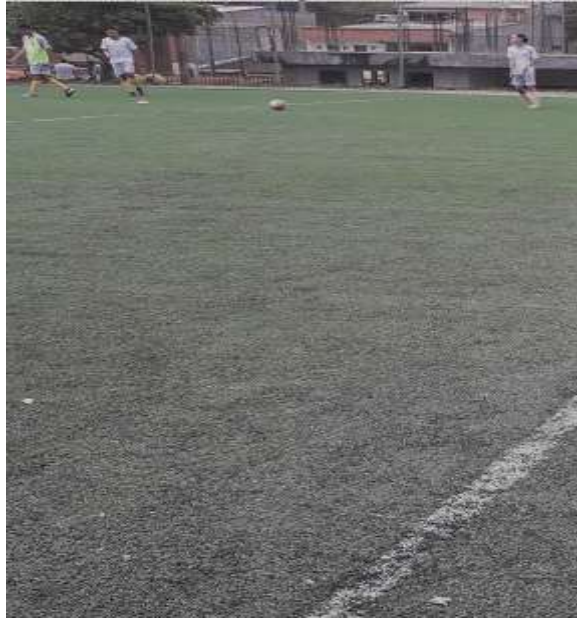
Fotografía N° 529. Deterioro en fibra de la grama sintética polideportivo 14 de octubre
