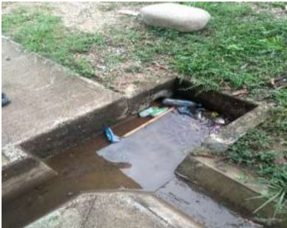
Fotografía N° 513. Desagües de aguas lluvias
