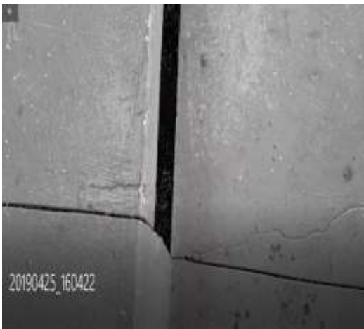
Fotografía N° 542. Gradería agrietada
