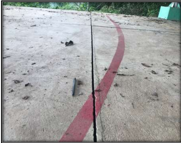
Fotografía N° 538. Las placas presentan niveles diferenciales
