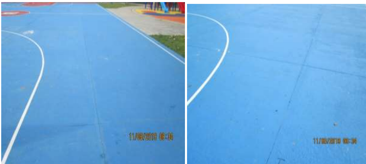
Fotografía 148. Muestran el mejoramiento realizado a las losas que presentaban patologías y el acabado de la cancha multifuncional en el parque La Casimiro.
