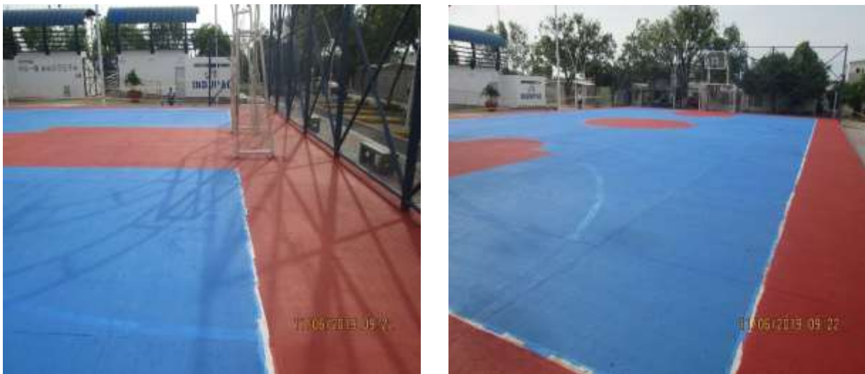
Fotografía 138. Muestran el mejoramiento realizado del acabado de la cancha multifuncional en el parque La Victoria.
