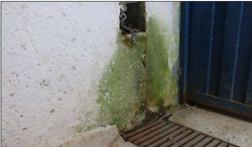
Fotografía 166. Detalle de uno de los muros perimetrales, en el pasillo que conduce al espacio adecuado bajo la tarima al aire libre.
