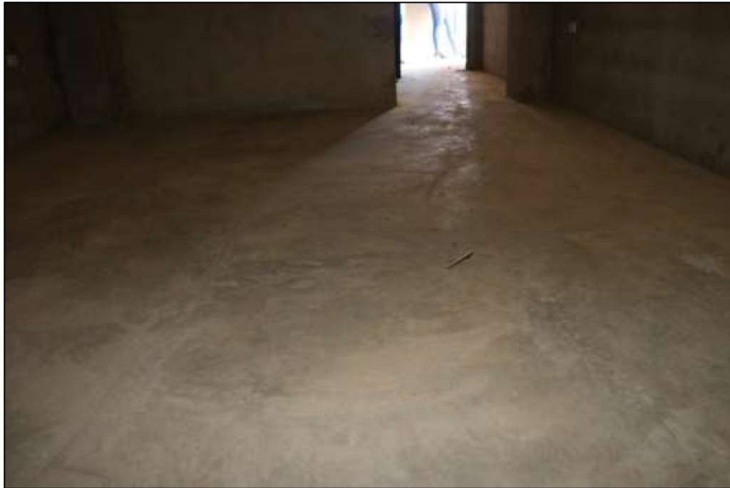
Fotografía 379 Vista general de la placa de contra piso, construida en uno de los camerinos adecuados bajo las graderías.
