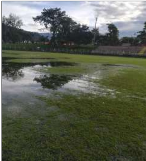
Fotografía 230. Vista general de otra sección de la zona central de la cancha de fútbol (imagen rotada 90° hacia la izquierda). En esta imagen quedó registrado el nivel de encharcamiento ocasionado en el campo deportivo, luego un fuerte aguacero (Fotografía tomada por funcionario del IMDER del municipio).
