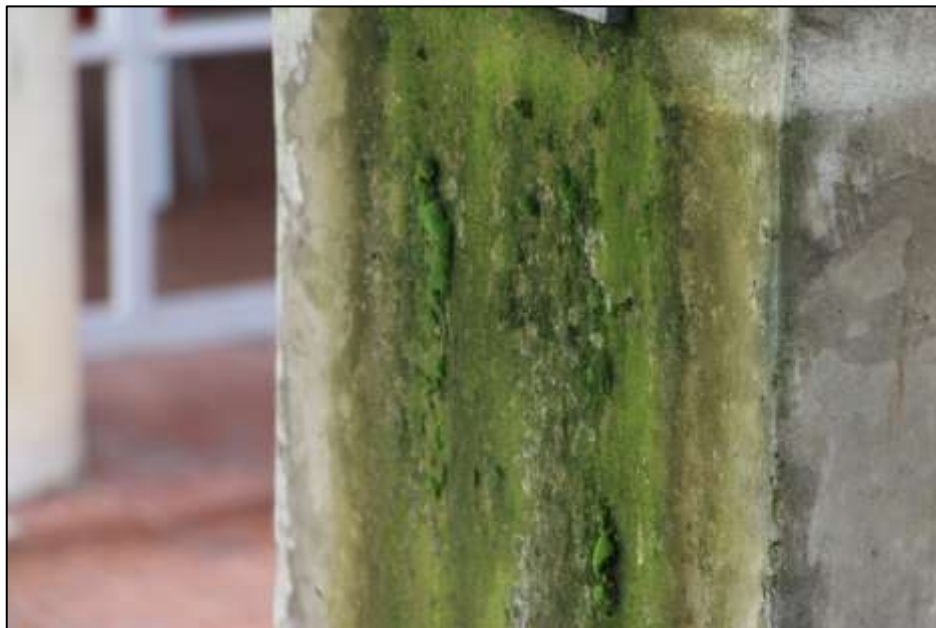
Fotografía 160. Detalle de una de las superficies de concreto, de la imagen anterior.
