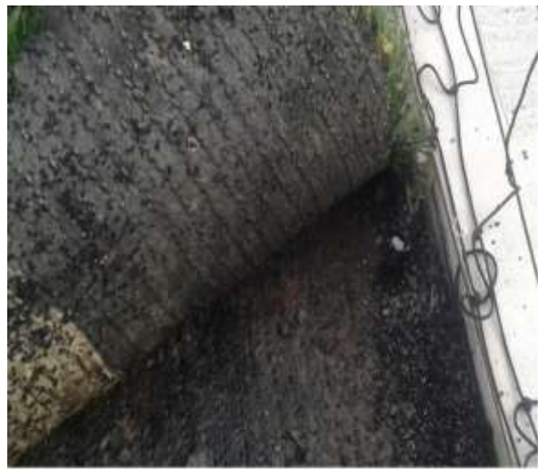
Fotografía N° 475. Levantamiento Grama Sintética
