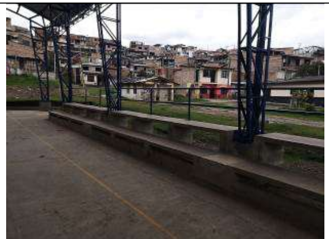
Fotografía 131 Gradería en mampostería instalada en el polideportivo.
