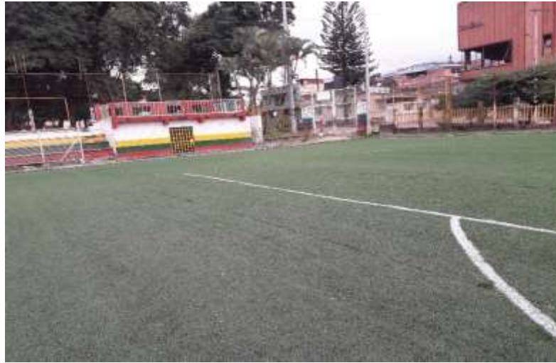
Fotografía N° 527. Levantamiento en pegues o uniones de la grama sintética polideportivo 14 de octubre
