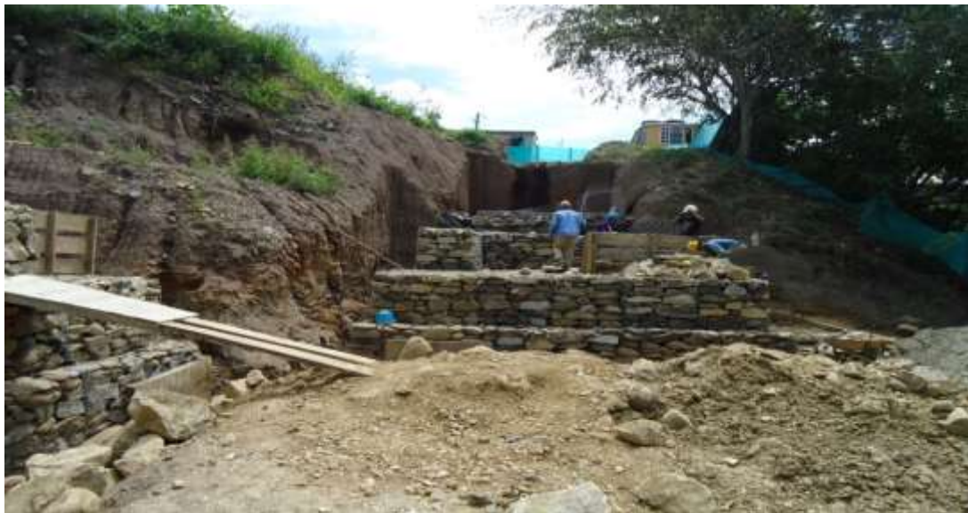
Fotografía 151. Muro de contención del costado frontal del terreno 26/04/2018
