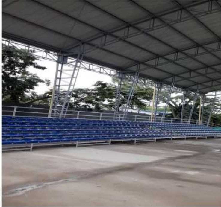
Fotografía N° 459. Gradería Polideportivo – foto tomada por el equipo auditor.
