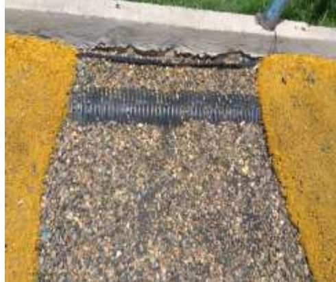
Fotografía 25 Subbase de piedra de canto rodado expuesto
