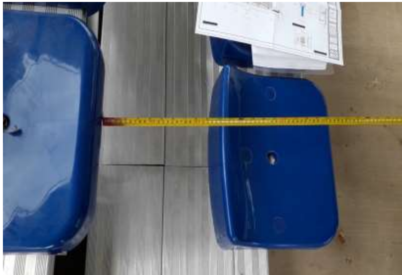
Fotografía N° 460. Espacio entre las filas de 26 cm - foto tomada por el equipo auditor.
