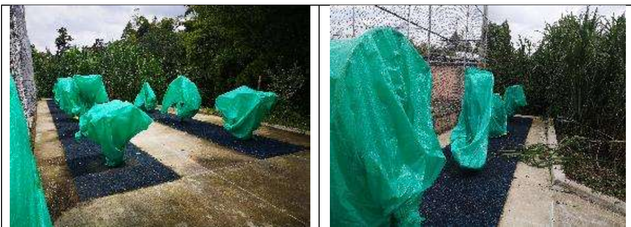
Fotografía 133 Detalle del parque yanaconas en la ciudad de Popayán, nótese los elementos cubiertos de poli sombra y la vegetación sobre la cubierta de caucho, poniendo en peligro su estabilidad.
