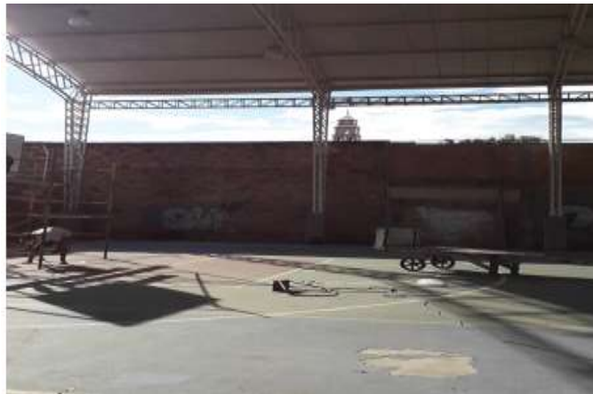
Fotografía N° 540. Recubrimiento reparado (Parche azul claro) y averiado
