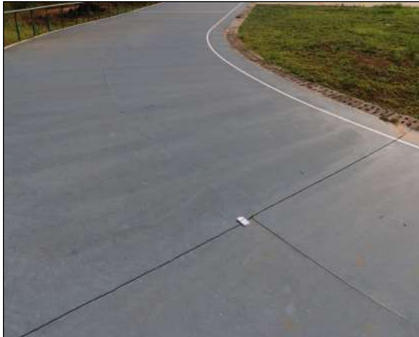
Fotografía 320 Vista general de una sección de la pista de patinaje (patinódromo), al término de una de las curvas. En este pavimento, se evidenció desplazamiento del concreto construido, en mayor medida en las juntas constructivas desarrolladas por el contratista. La debilidad constructiva, generó que las mismas se apreciaran abiertas y en deterioro progresivo.
