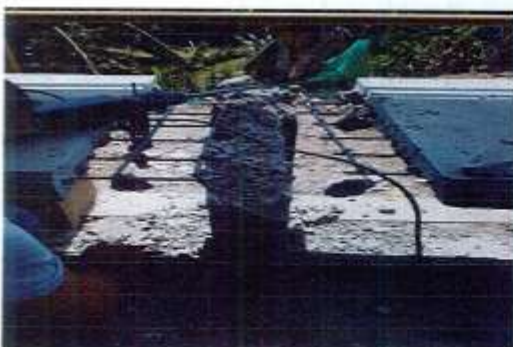
Fotografía 232. Detalles de las reparaciones realizadas por el Contratista de obra, en los sitios de apoyos de las placas de concreto. Estas imágenes fueron aportadas por el Secretario de la Veeduría Municipal.
