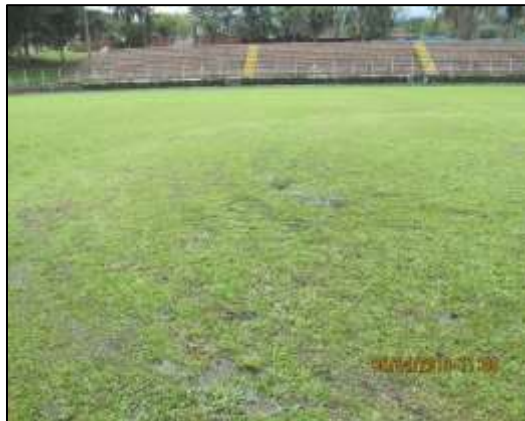
Fotografía 225. Vista general de una sección de la zona central de la cancha de fútbol. Se evidenció la misma lesión ya descrita, en la obra construida.
