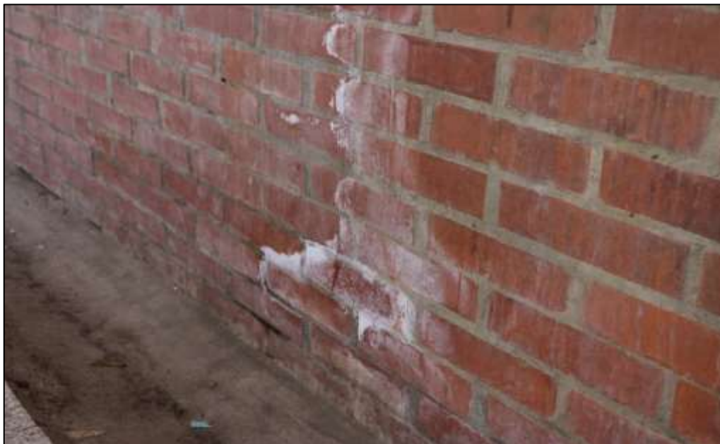
Fotografía 171. Detalle de una sección del muro perimetral construido detrás de uno de los arcos, dentro del polideportivo de este escenario deportivo.
