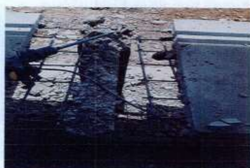
Fotografía 232. Detalles de las reparaciones realizadas por el Contratista de obra, en los sitios de apoyos de las placas de concreto. Estas imágenes fueron aportadas por el Secretario de la Veeduría Municipal.
