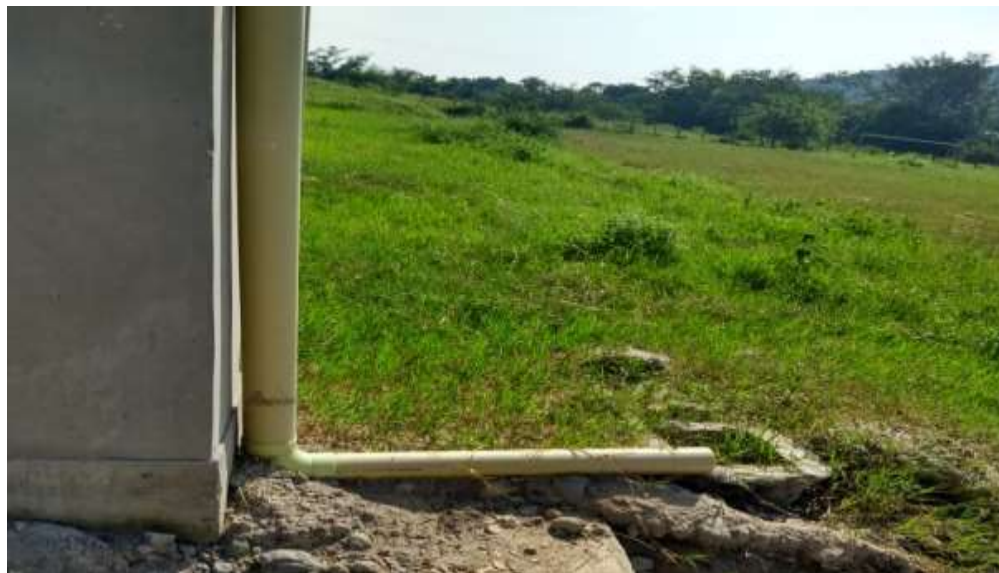
Fotografía N° 526. Final de la bajante del Polideportivo de la Vereda La Manga, tomada el 9 de abril de 2019 por el equipo auditor de la CGR en el Municipio de Valle de San Juan, Departamento del Tolima.
