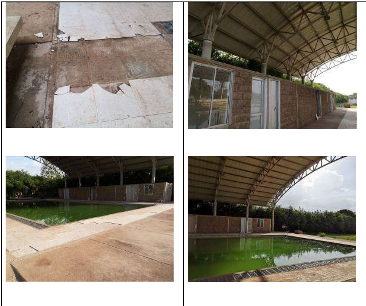
Fotografía 296 Condiciones de la piscina semiolímpica
