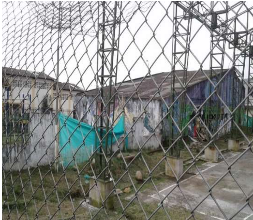
Fotografía N° 465. Estado de obra Polideportivo barrio Jaramillo. Al fondo se pueden observar los tubos retirados.
