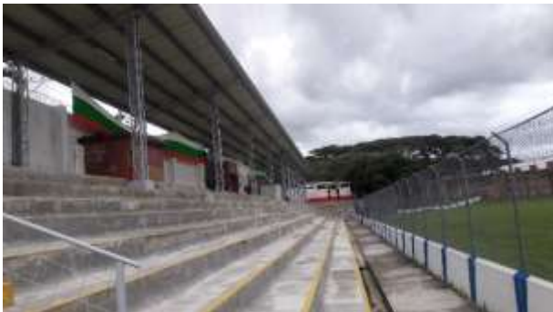
Fotografía N° 566. Vista general del proyecto
