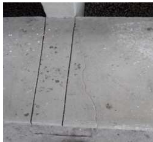
Fotografía N° 543. Gradería agrietada
