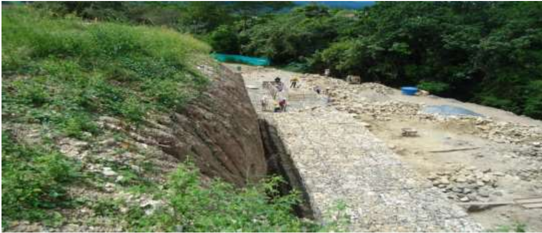
Fotografía 150. Muro de contención un costado lateral del terreno 26/04/2018
