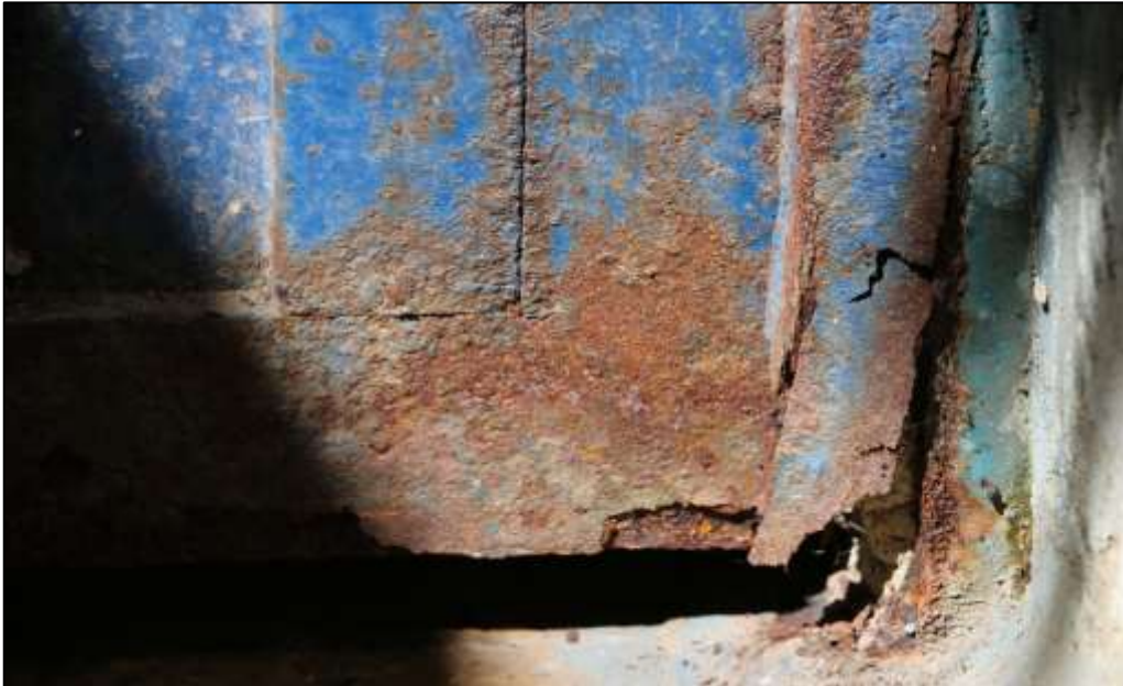
Fotografía 165. Detalle de una sección de la puerta instalada a la entrada al espacio adecuado bajo la tarima al aire libre (parte baja de la puerta).
