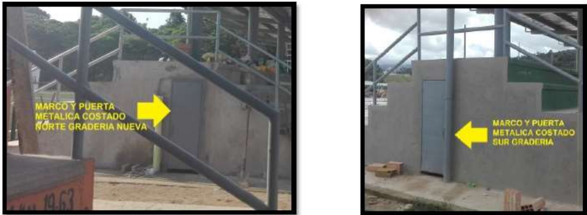
Fotografía 122 Marcos y puertas metálicas colocadas por contratista bajo gradería nueva
