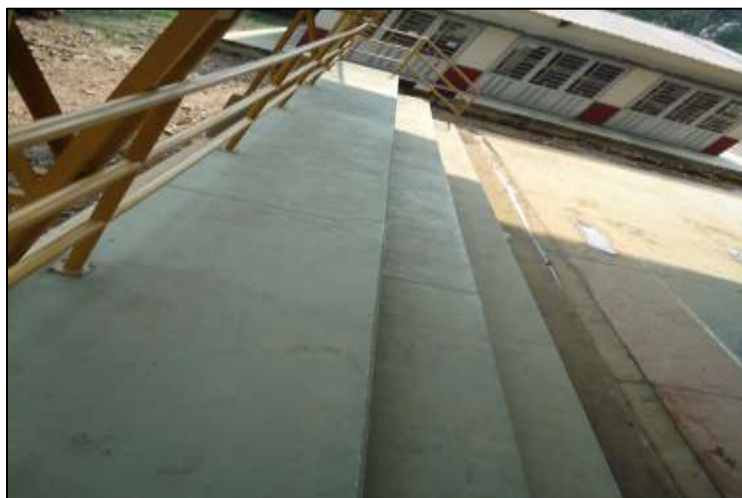
Fotografía 233. Vista general superior de un tramo de la gradería construida
