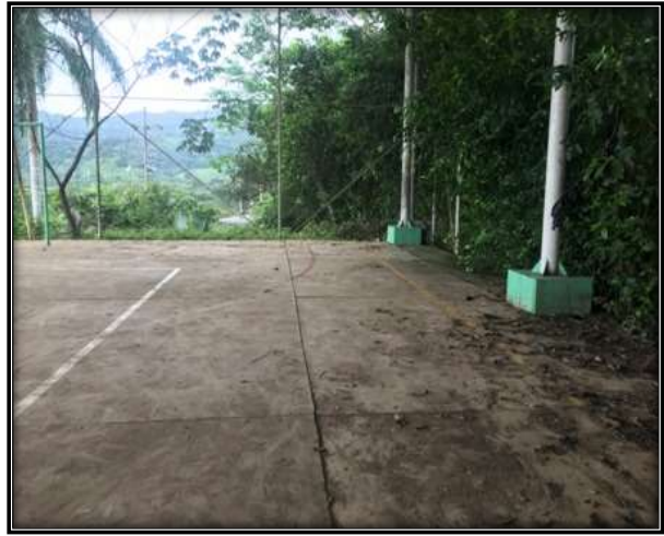
Fotografía N° 539. Las placas presentan niveles diferenciales
