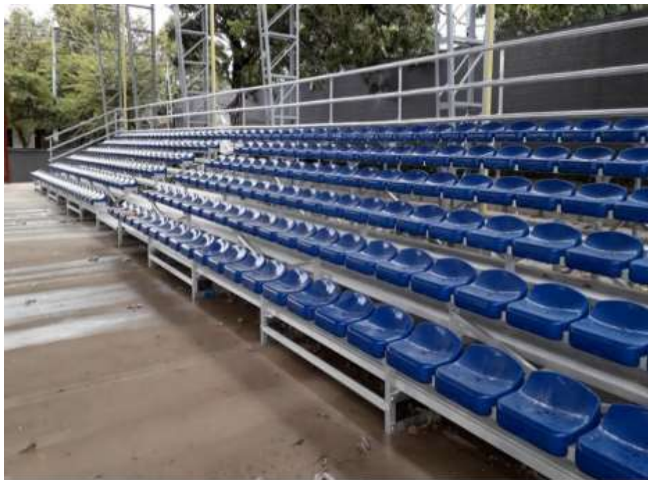
Fotografía N° 458. Gradería Polideportivo. Filas horizontales – fotografía tomada por el equipo auditor.
