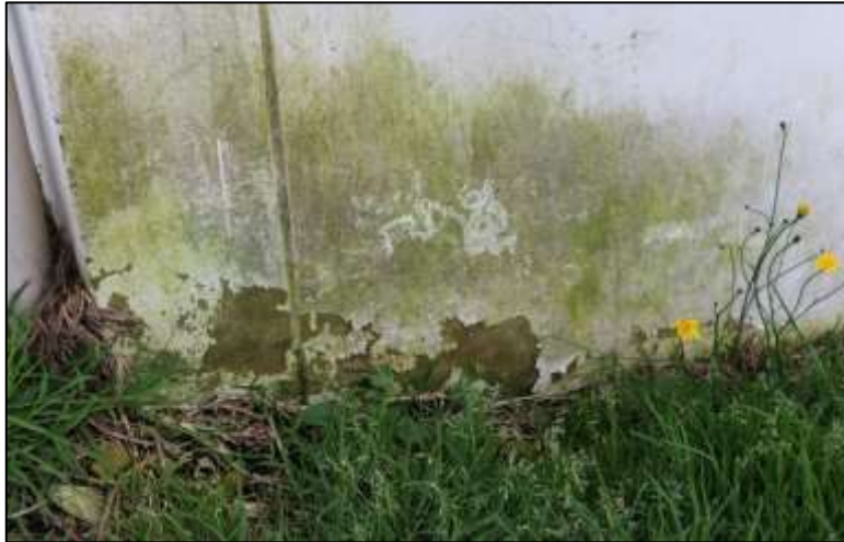
Fotografía 258. Detalle del muro registrado en la imagen anterior (esquina inferior). Se evidenció en este sitio, pérdida parcial de la pintura de acabado y huella de materia vegetal.
