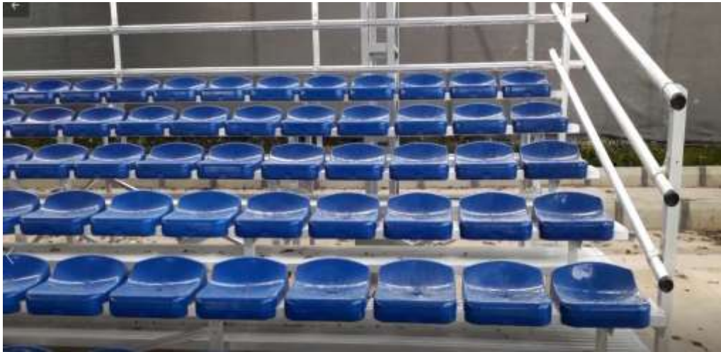
Fotografía N° 461. Gradería sin espacio y acceso lateral. - foto tomada por el equipo auditor.
