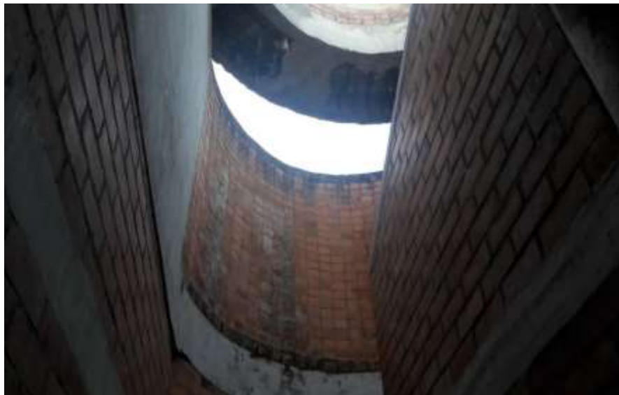
Fotografía N° 561. Parte de la escalera en donde no se instaló el Domo. Foto Tomada por el Auditor el 04 de abril de 2019.
