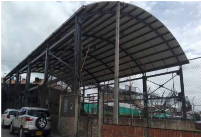
Fotografía 176. Vista General de la Cubierta Polideportivo Barrio Obando 01/04/2019
