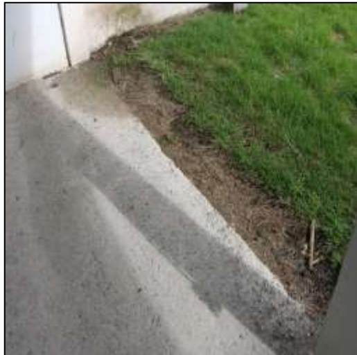
Fotografía 253. Vista general de otra sección de placa de contra piso (borde de placa frente a una de las zonas de tiro al aire libre).
