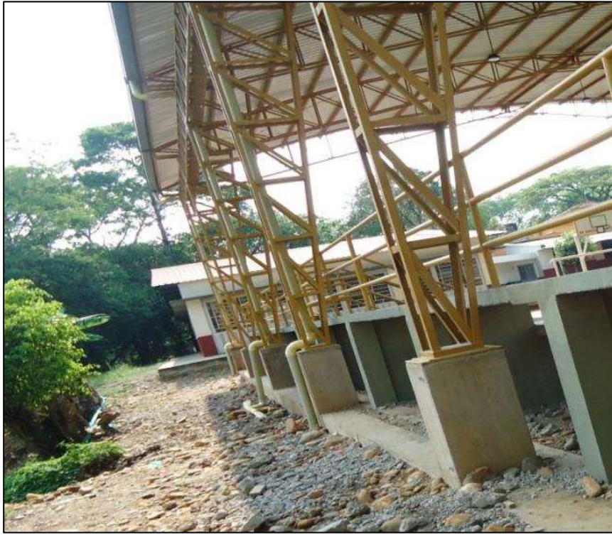
Fotografía 238. Vista general posterior del polideportivo
