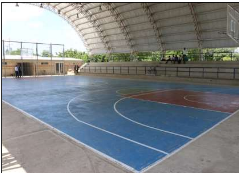
Fotografía 363 Vista general de la cancha multideportiva cubierta.
