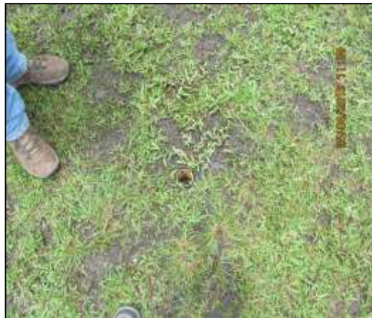
Fotografía 228. Vista general de otra sección de la zona central de la cancha de fútbol. Se evidenció la misma lesión ya descrita, en la obra construida.
