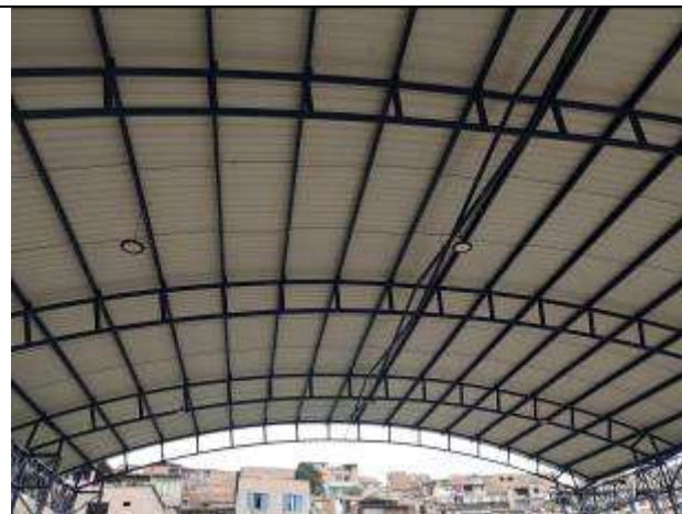
Fotografía 130 Cubierta en teja termoacústica
