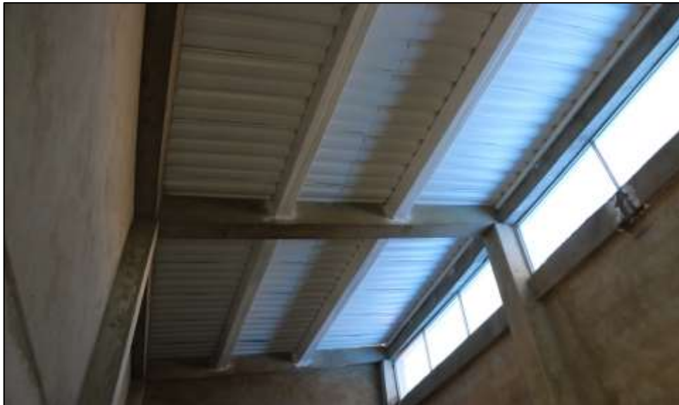
Fotografía 193. Vista general de la cubierta, en el cuarto de los tanques de almacenamiento de agua, a un costado de las baterías sanitarias adecuadas. Se evidencia el tipo de estructura metálica de la cubierta.
