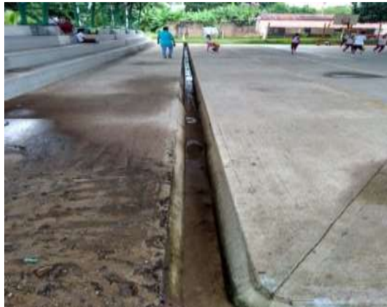
Fotografía N° 515. Detalle de la canalización
