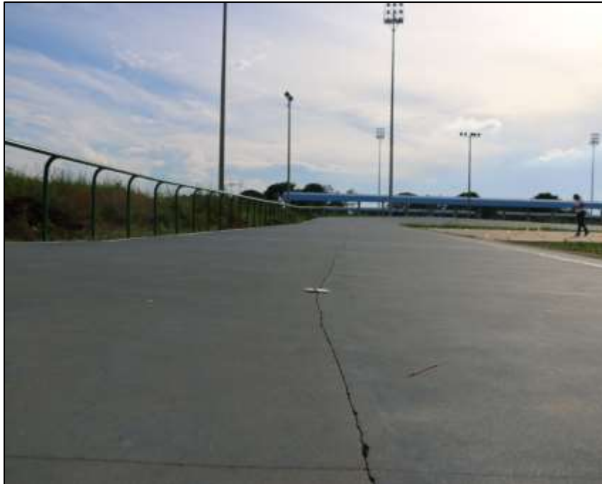
Fotografía 324 Vista general de una sección de la pista de patinaje (patinódromo). En la imagen se evidencia la lesión, ya descrita en imágenes anteriores.
