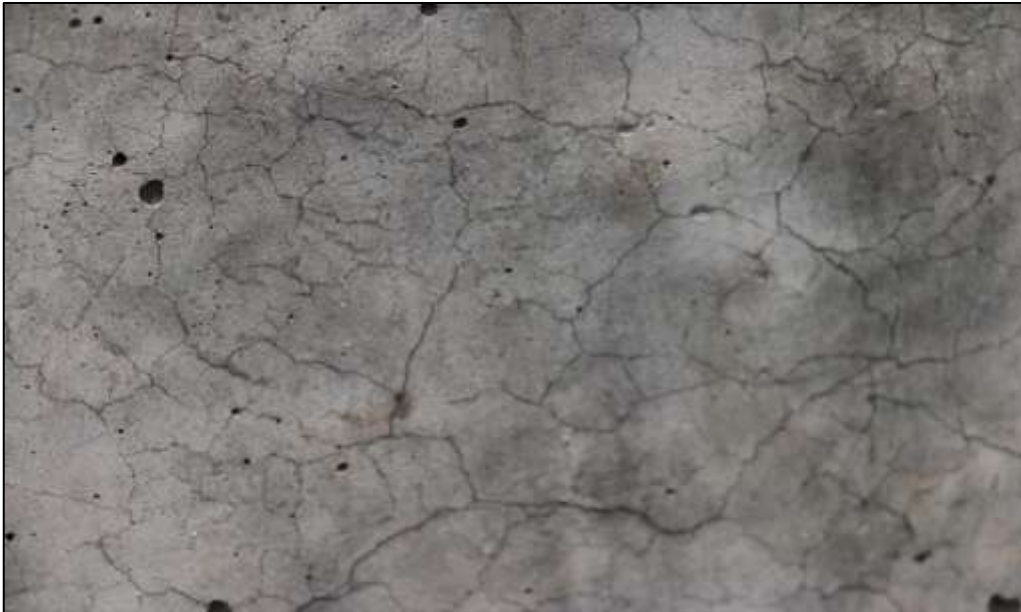
Fotografía 158. Detalle de una de las caras de la columna de concreto registrada en la imagen anterior. En la fotografía se evidencia el estado evidenciado de la superficie de los concretos de estos elementos.
