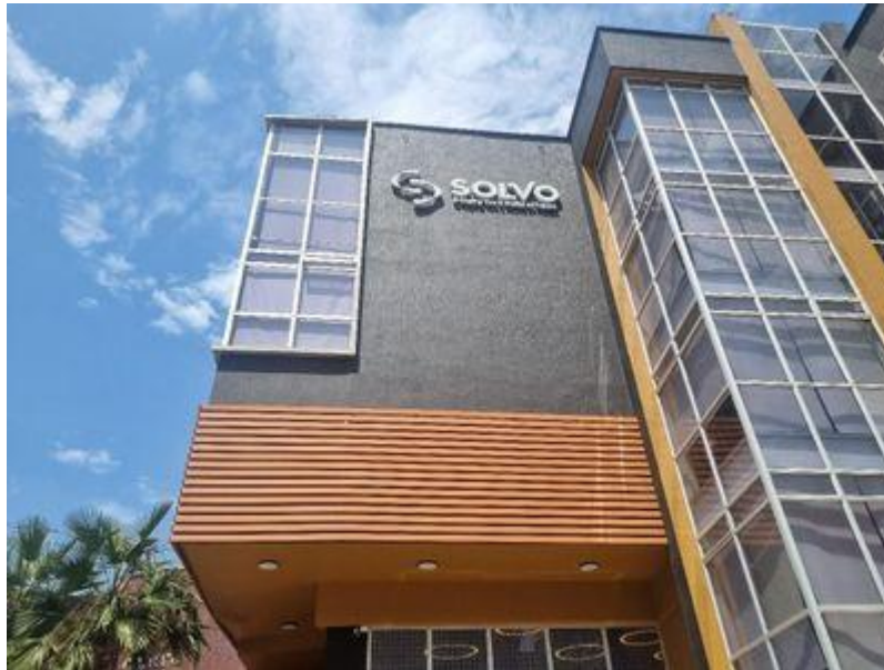
Se observa vista frontal del predio visitado.
