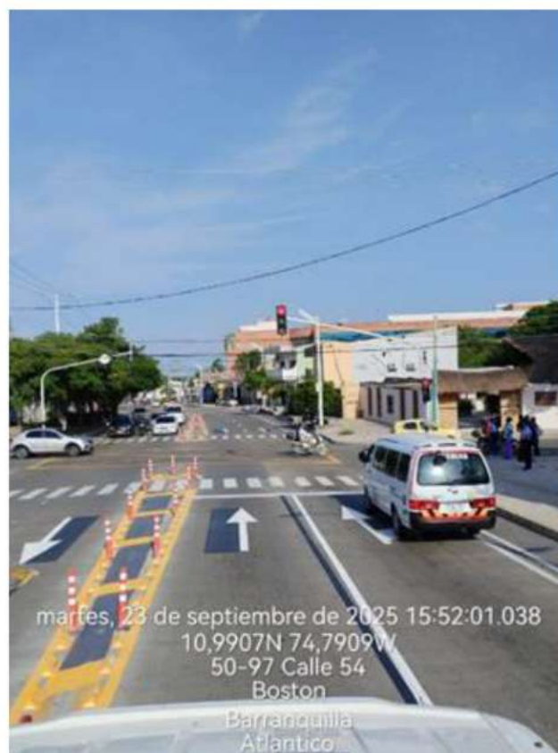
Figura 11 Implementación de nuevos resguardos peatonales y mantenimiento de los existentes en Calle 54 con Carrera 50
