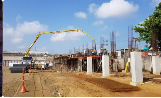
Estado de la obra
