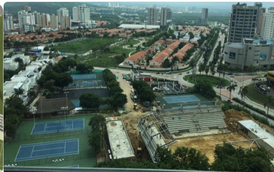
Estado de la obra
