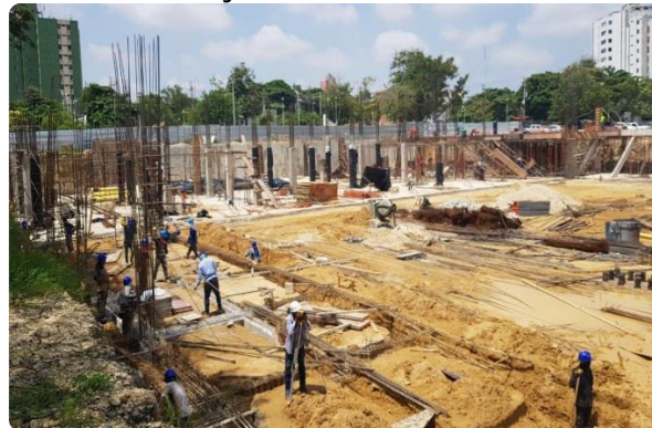
Estado de la obra
