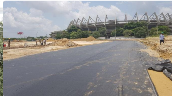
Estado de la obra
