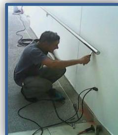
**Ilustración 9 reinstalación de pasamano flotante**
