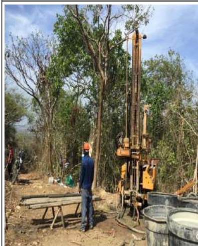
Fotografía No. 5 Exploración Geotécnica de campo
