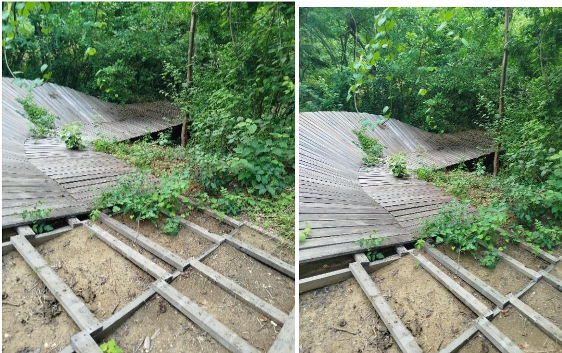
**FOTOS 5 Y 6:** VISTA ESTADO ACTUAL PISTA DE CICLOMONTAÑISMO, ESTA ESTRUCTURA EN MADERA HACE PARTE DE LA PISTA, PERO HA SIDO OBJETO DE VANDALISMO POR FALTA DE SEGURIDAD EN LA OBRA.
