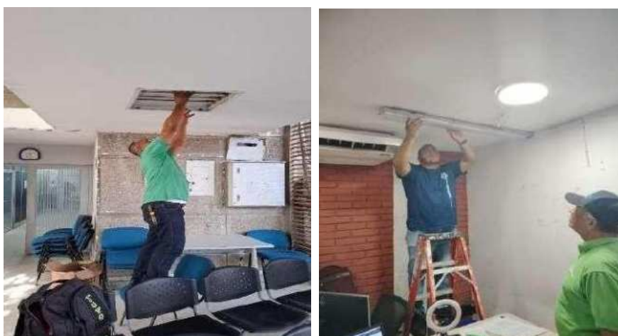
Se realizó mantenimiento y cambio de luminarias en la casa de justicia la paz con el apoyo de Secretaría General.
