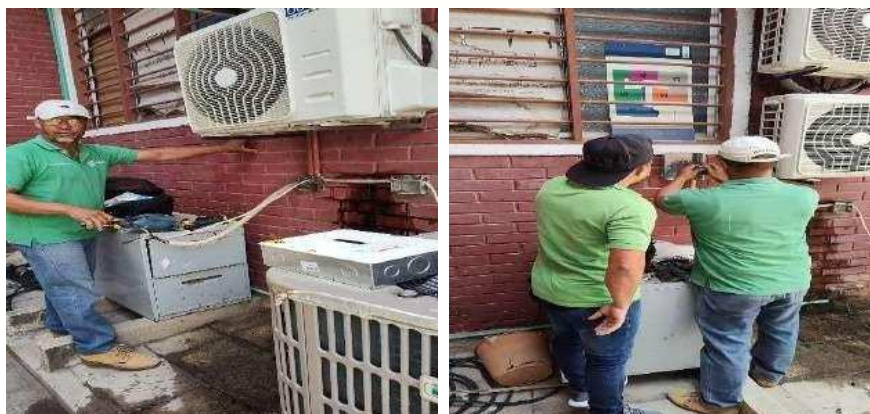
Se realiza mantenimiento de los aires acondicionados.
